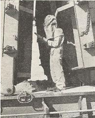
צביעת דופן האניה באמצעות דוברת. Painting vessel's hull utilizing a floating raft.
