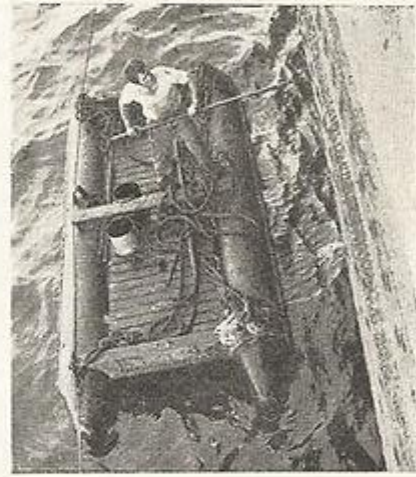
נקוי החלודה בהתות חול על החלק הפנימי של מכסי המחסן. (שיטה הסנדבלסט). Combatting rust by sandblasting on the inner side of the hatch pontoon.
