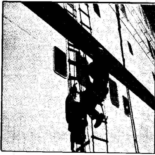
דוגמה חיובית - כלי עבודה מאובטחים, קסדה וחגורת בטיחות בשימוש. A GOOD EXAMPLE - TOOLS SECURED, SAFETY HELMET AND BELT WORN.
